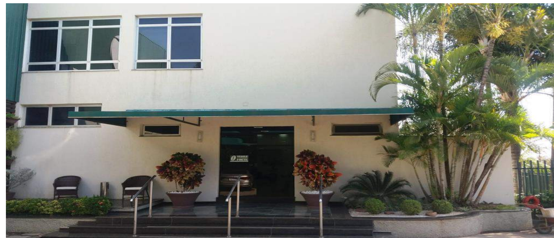
Entrada da recepção
