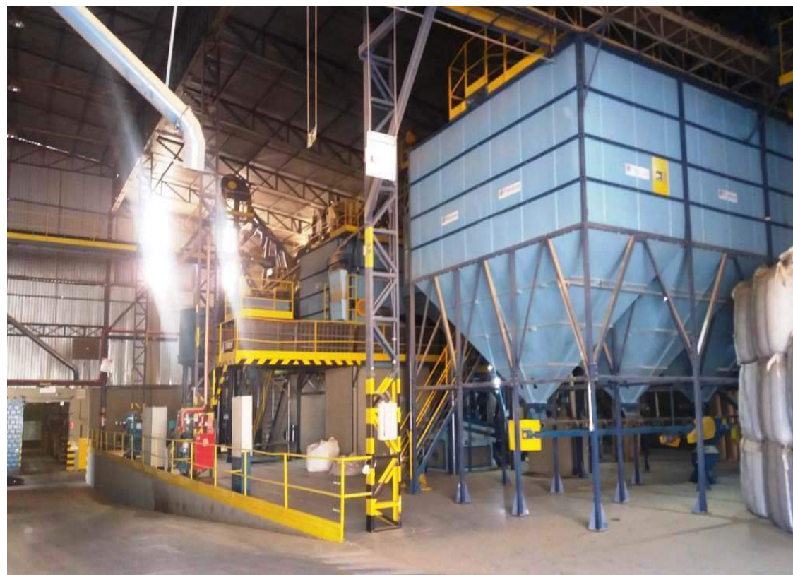
Preparo e Armazenagem de Café
