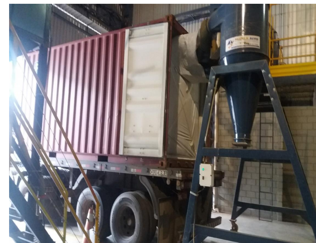
Preparo e Armazenagem de Café
