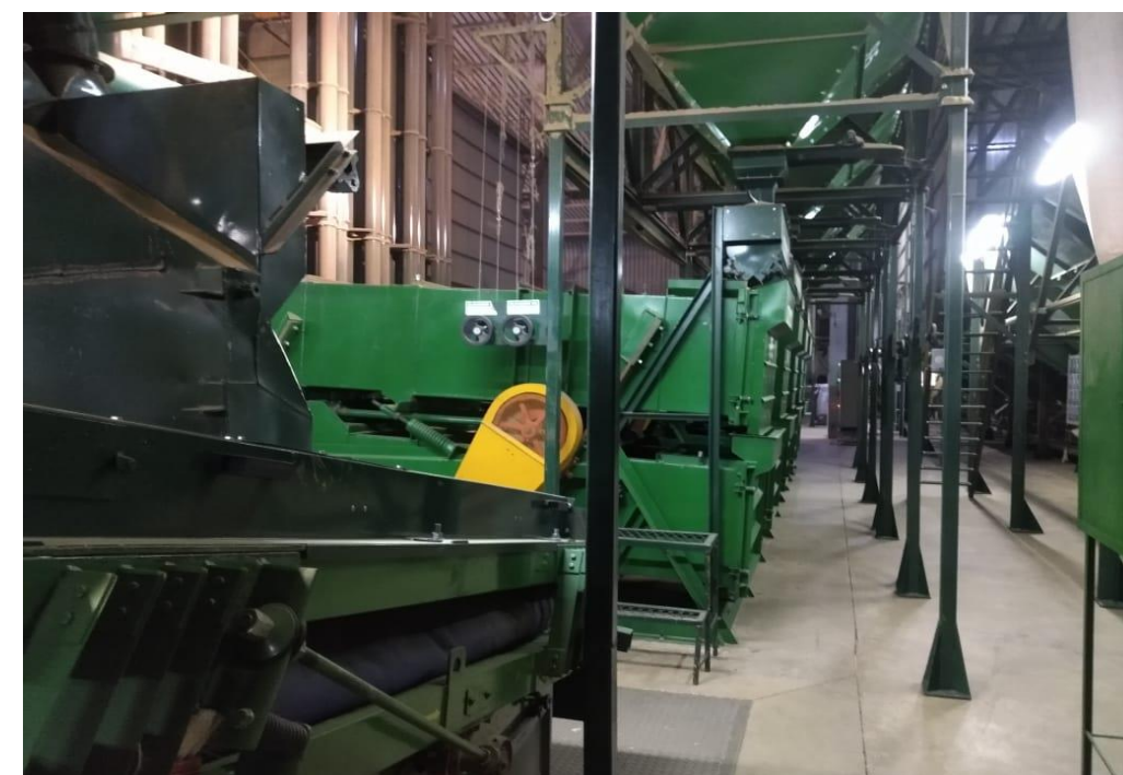
Preparo e Armazenagem de Café
