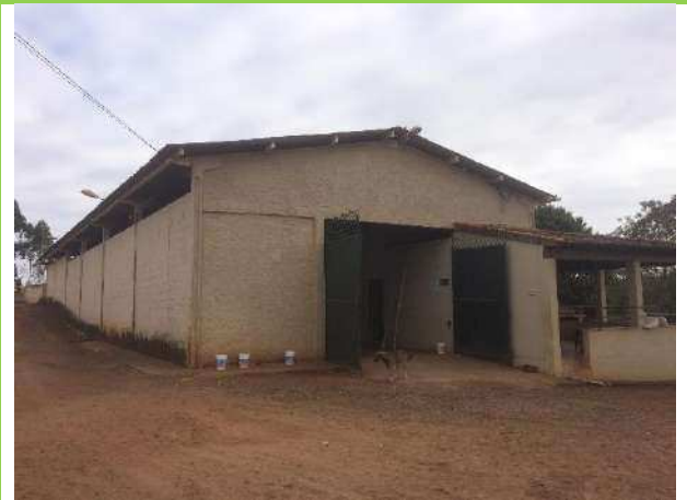
Foto 7a: Galpão com Escritório e Oficina
