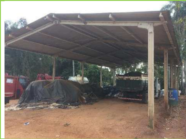
Foto 11: Cobertura para depósito de adubo
